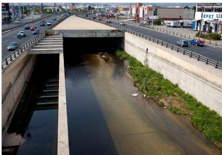
Κηφισός : άποψη κάτω από τον αυτοκινητόδρομο Αθήνας-Λαμίας Πηγή: Wikipedia.
